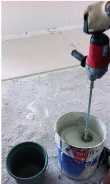
Foto 1- Mistura Mecânica da Argamassa
